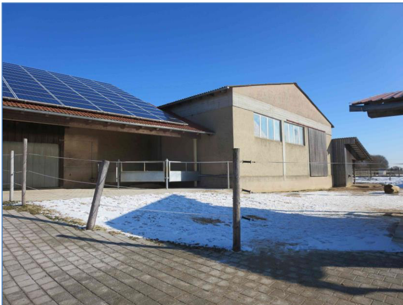
Abbildung 5: Teil der Auslaufläche Aktivstall Gilch mit Eingang in den Ruheraum (links)
